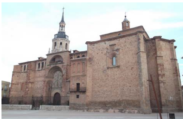
Fachada de la Iglesia a la Plaza de la Constitución
